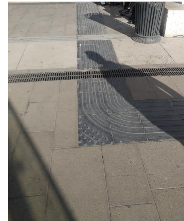
Bande podotactile Thermocollée, Milan (Source : Association Etudes Urbaines)
