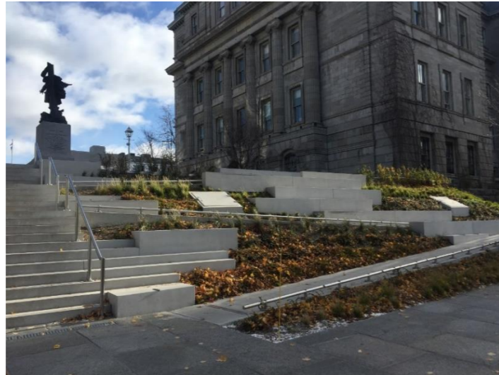
Rampe d'accès aménagée à Montréal – Place Vauquelin- (Source: Association Etudes Urbaines)
