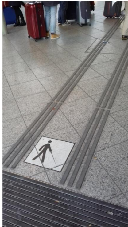
Des barres guides en reliefs sont posées au sol afin de diriger les malvoyantes.
