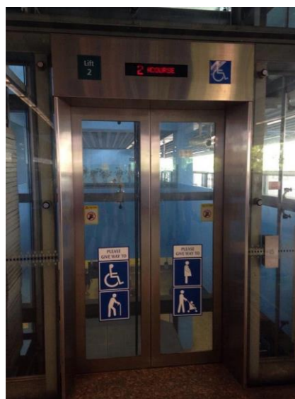
Figure 2: Ascenseur menant sur les quais
