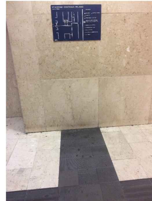
Figure 12 – Milan, Bande podotactile avec transpondeur et panneau d'information en Braille à la Gare Centrale
