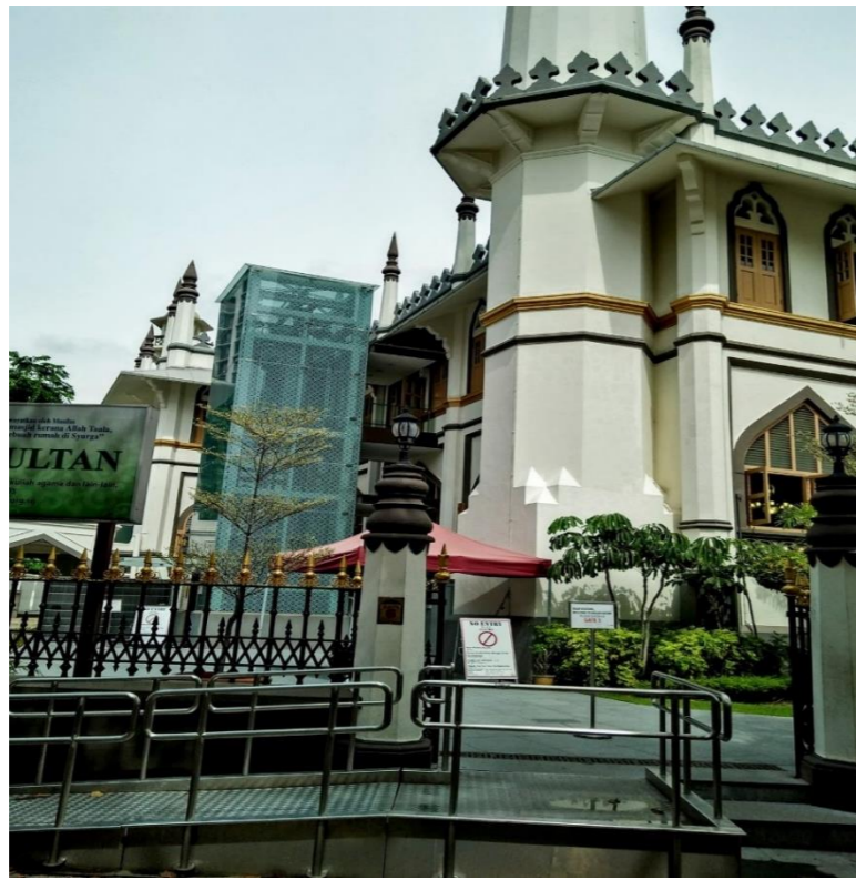
Ascenseur intégré dans un bâtiment ancien, Singapour (Source : Association Etudes Urbaines)
