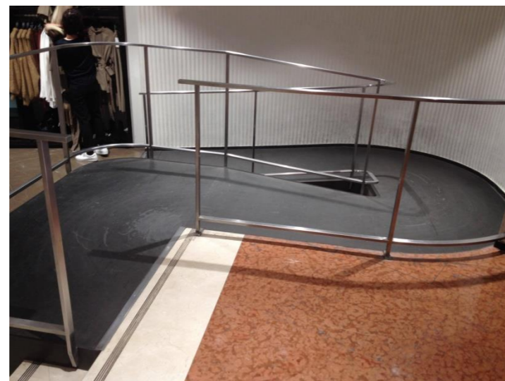
Figure 2: Rampe d'accès boutique Zara Milan
