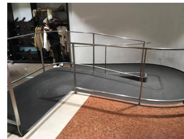
Figure 7: Rampe d'accès pour les PMR dans un magasin
