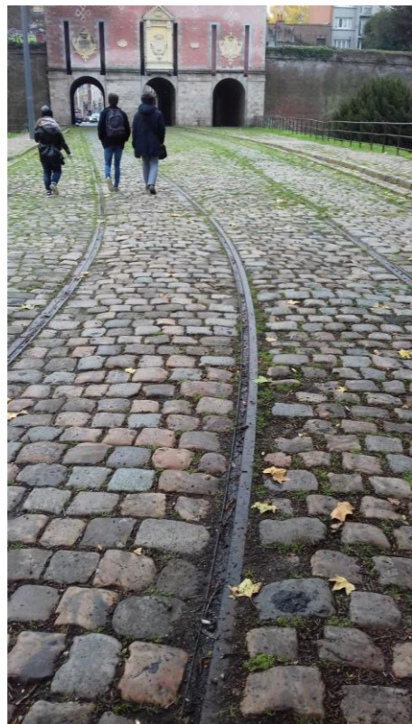
Anciens rails pouvant être confondu avec des guides pour malvoyants.
