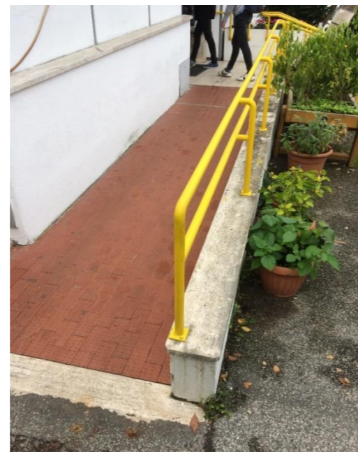
Figure 4 – Rome, Rampe d'accès à l'entrée de l'Association F.I.S.H.
