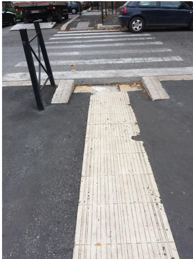
Figure 5 – Rome, Bande podotactile au niveau d'un passage piéton
