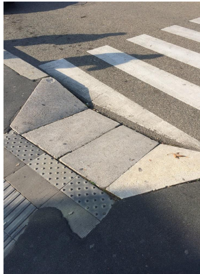
Figure 11 – Rome, Bande podotactile et rampe d'accès PMR au niveau d'un passage piéton
