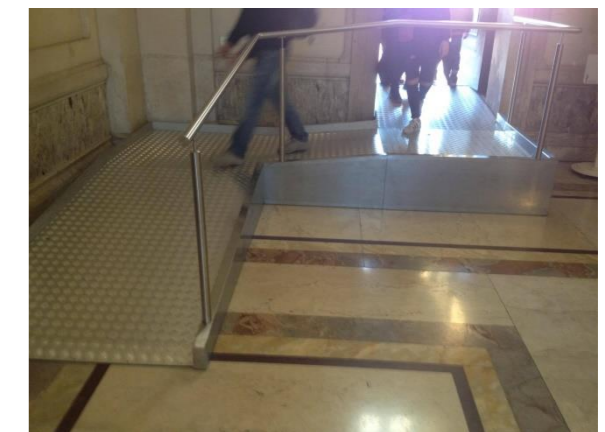
Figure 9 : Rampe d'accès terrasse Palazzo (Rome)
