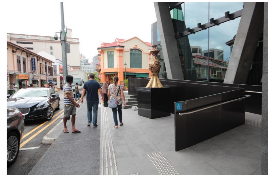
Rails de guidage à Singapour (Source: Association Etudes Urbaines)
