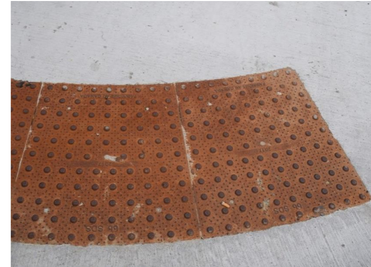
Plaque podotactile en fonte résistant mieux au déneigement à Montréal (Source : Association Etudes Urbaines)
