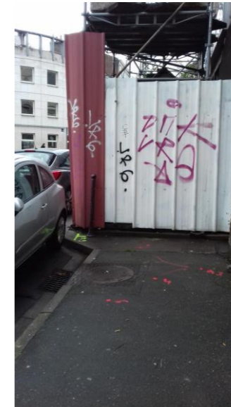
Trottoir où une personne en fauteuil ou aveugle va s'engager sans pouvoir le traverser à cause des travaux.
