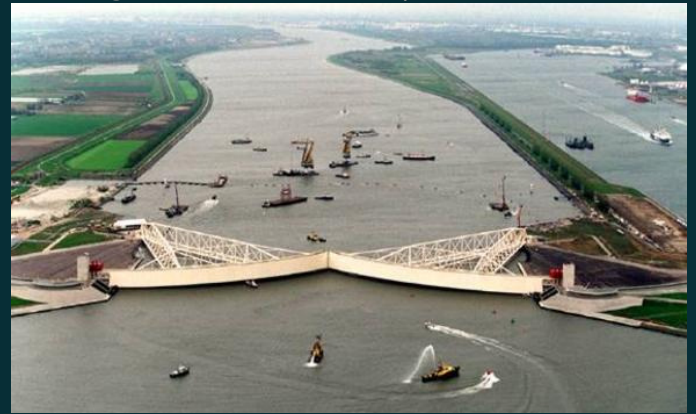
Figure 55 : Le Maeslantkering fermé ; Crédits : Wikipédia
