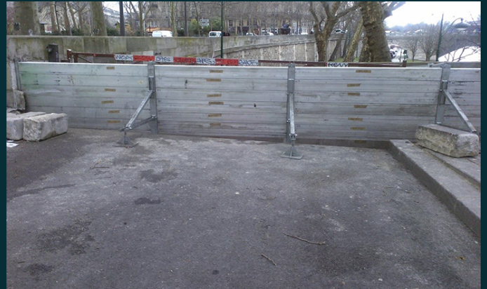
Figure 57 : Barrages installés en 2016; Crédits : Paris.fr
